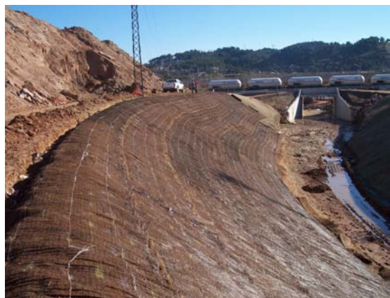
Instal·lació de la geomalla al llarg de tot el talús.
