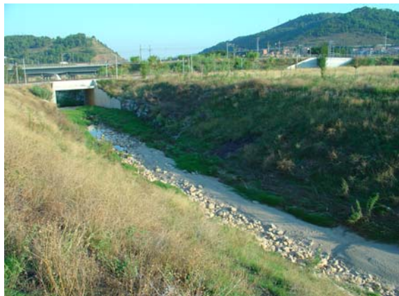
3 anys després d'acabar l'obra.
