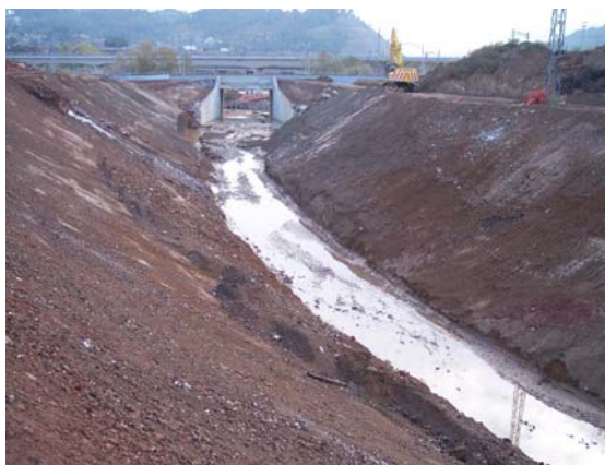
Reperfilat dels talussos.
