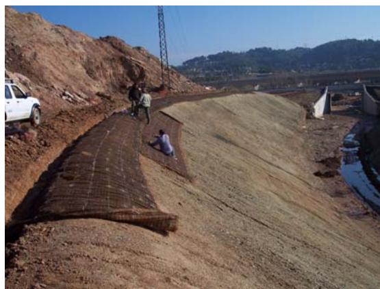
Hidrosembra i ancoratge superior de la geomalla C350.
