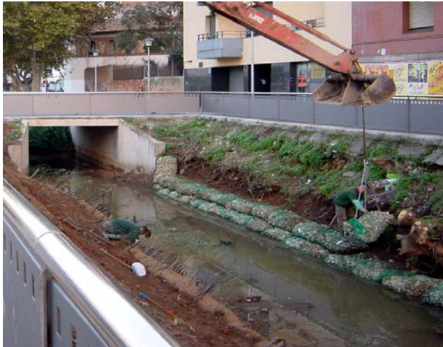
Imatges: instal·lació de Rock rolls TM i enfeixinat amb Fiber roll TM
