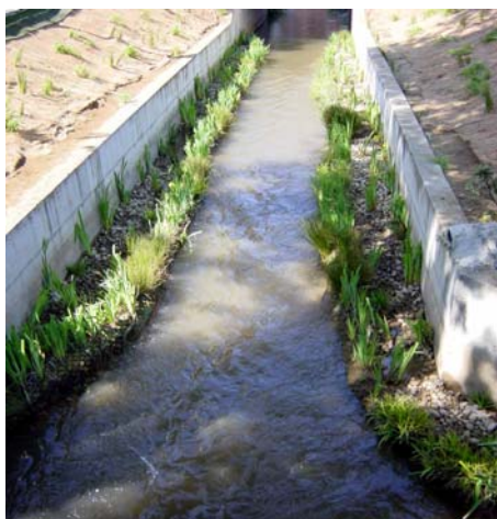
Actuació en el canal recent acabada .
