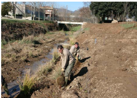
Imatges de la instal·lació dels Fiber Roll™ vegetalitzats
