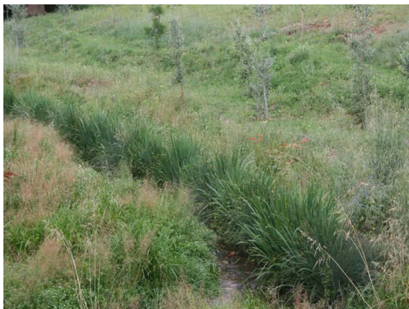
Imatge d'un tram de l'obra sis mesos després de finalitzats el treballs. En primer terme els Fiber Roll™ vegetatitzats ja desenvolupats.
