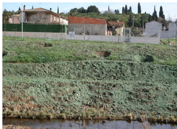
Imatges de la hidromanta HydraCX2 un cop projectada, amb els Fiber Roll™ en primer terme amb els helòfits encara amb aspecte hivernal.
