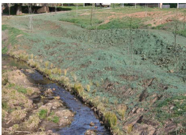
Imatges de la hidromanta HydraCX2 un cop projectada, amb els Fiber Roll™ en primer terme amb els helòfits encara amb aspecte hivernal.
