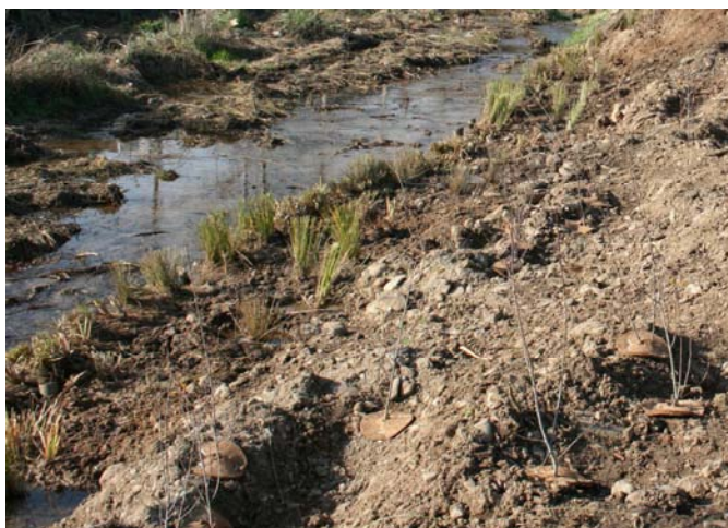
Unitats de Plant Plug™ plantats entre el Fiber Roll™ i el marge
