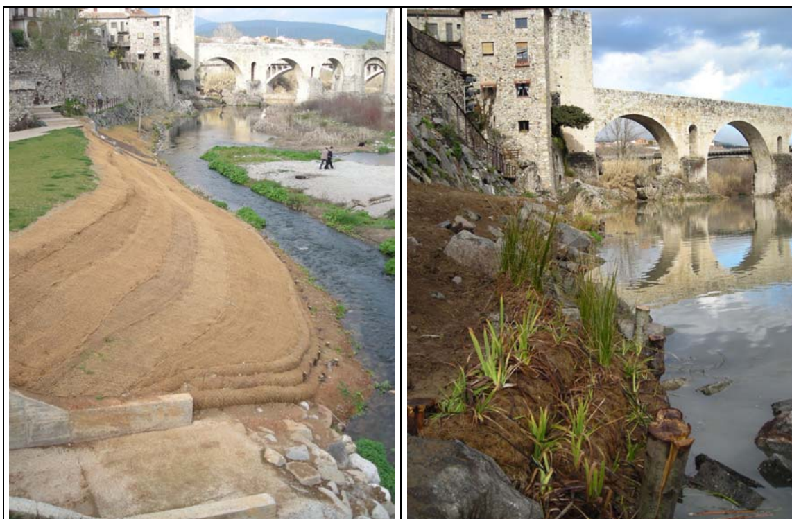
A l'esquerra vista de la ret de coco i en la seva part inferior un enfeixinat de Fiber Roll™ + arbust. I a la dreta imatge de l'enfeixinat de Fiber Roll™ vegetat.
