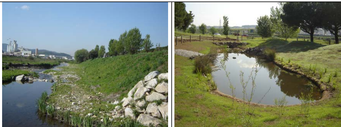
Foto esquerra: en primer terme Fiber roll TM vegetat i geomalla permanent C-350 al riu Congost.
