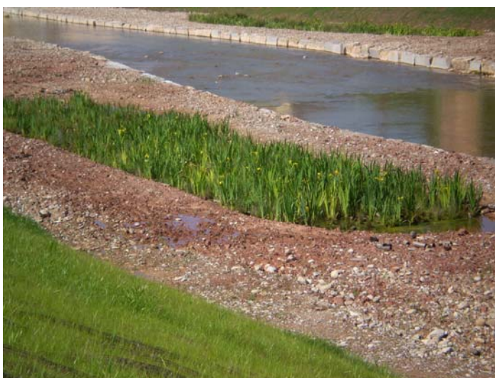
En la primera foto s'aprecia la ubicació dels llits dels Plant carpet™, després l'acopi i la plantació, i finalment l'aspecte al final de l'obra.
