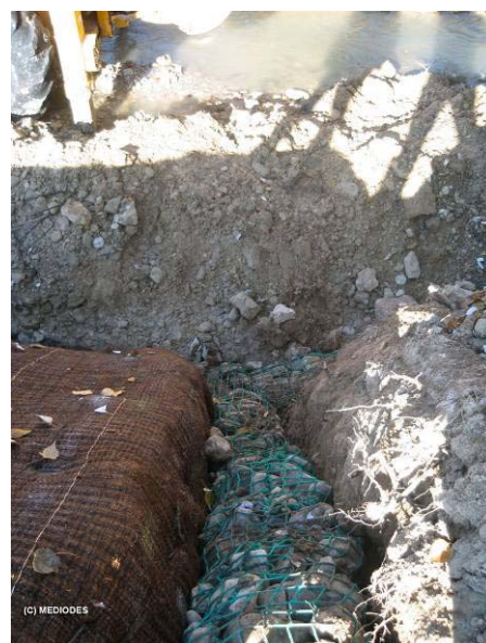
Imatge de geomalla C350 instal·lada, i detall del reforç amb gabió flexible tipus Rock roll TM de l'inici del tram amb la geomalla.
