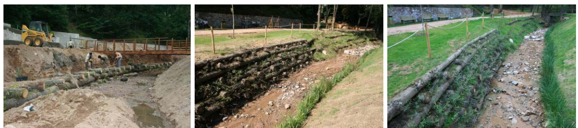
Durant la construcció d'un entramat tipus Krainer i un cop ja finalitzat
