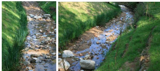
Imatges dels Fiber roll™ vegetats ja instal·lats a la llera
