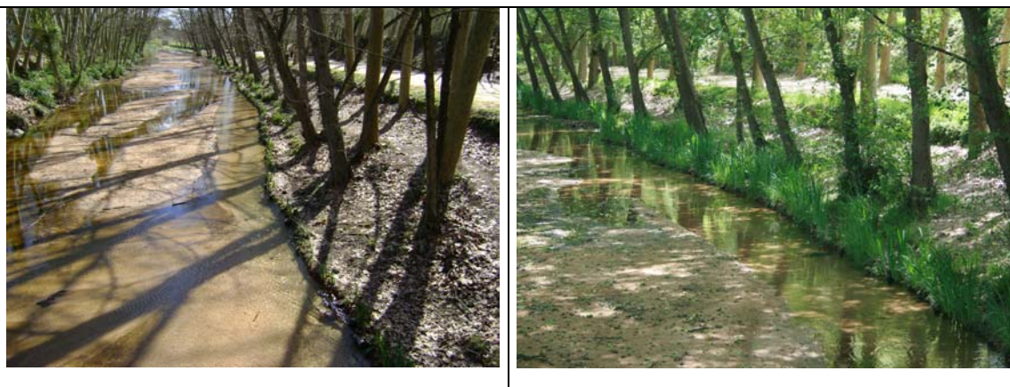
Foto esquerra: Fiber rolls™ després de ser instal·lats
