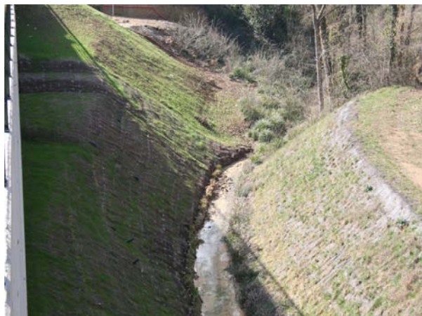
Vista general dues setmanes després de la finalització dels treballs del marge dret.
