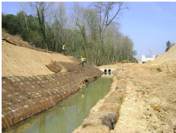
Procés de instal·lació de la geomalla permanent C350 Vmax i fixació amb estacues del Fiber Roll™ vegetaltitzat a la base del marge esquerra.
