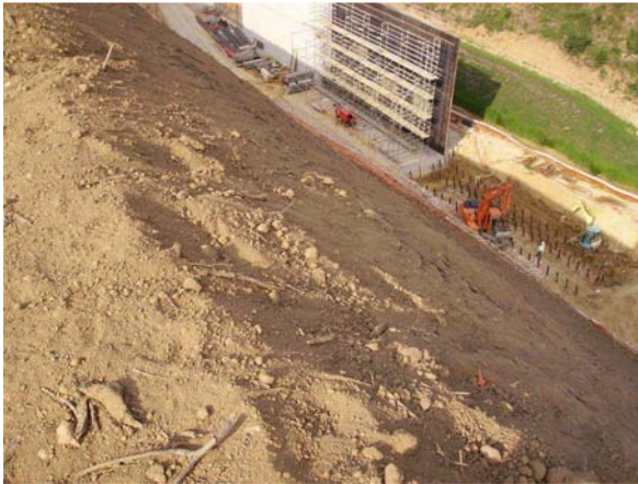
Imatge de la construcció del mur de contenció de la traça de la LAV. A l'altra banda del mur s'aprecia el marge esquerra ja vegetat.
