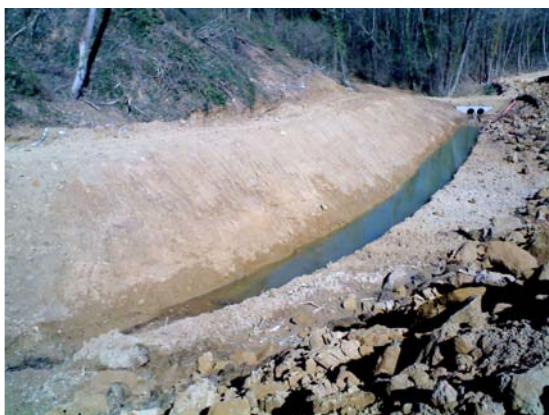
Imatges de la riera a l'inici dels treballs, i l'esquema de l'actuació amb la geomalla permanent, el gabió flexible fixant la geomalla i estabilitzant la base, i el Fiber Roll™ vegetatitzat.
