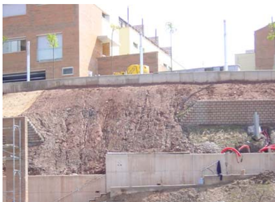
Imatge abans i un cop instal·lada la geomalla
