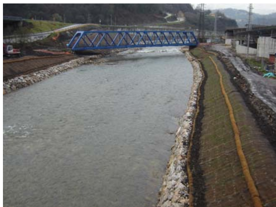
Dues panoràmiques de l'obra
