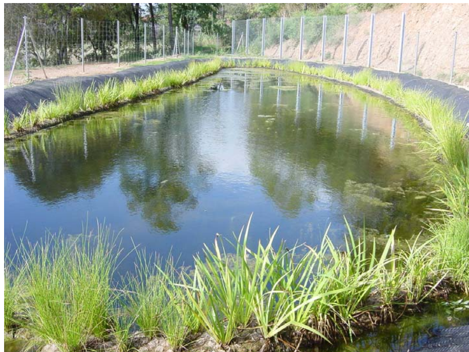
Imatge un cop finalitzada la instal·lació.
