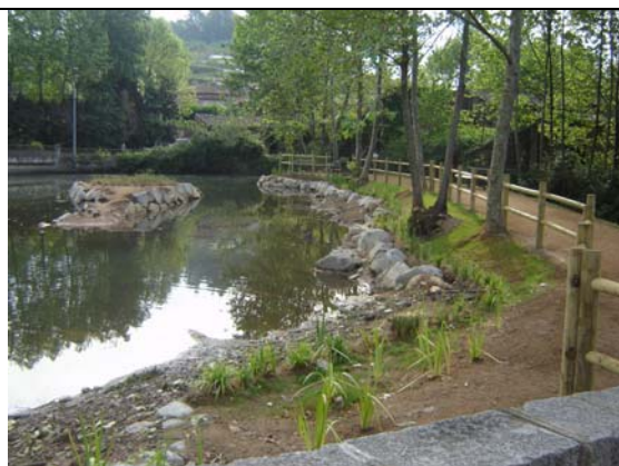
Instal·lació de Fiber roll™ vegetat.
