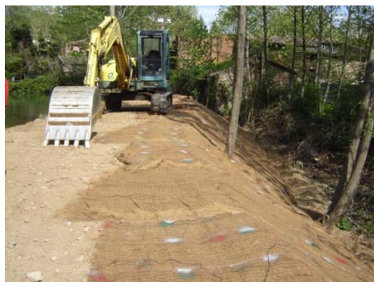
Instal·lació de la geomalla C-125BN de NAG.
