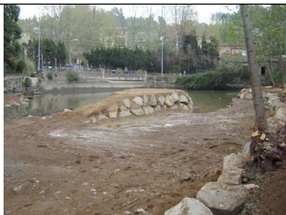
Imatge de l'obra abans de l'instal·lació
