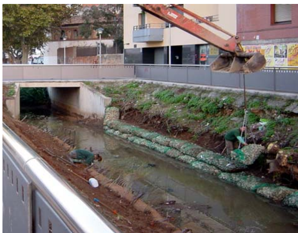
Imágenes: instalación de Rock roll™ y vista del enfajinado de Fiber roll™
