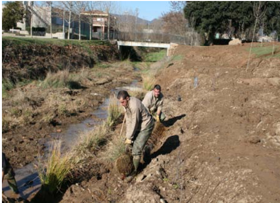
Imágenes de la instalación de los Fiber Roll™ vegetalizados.
