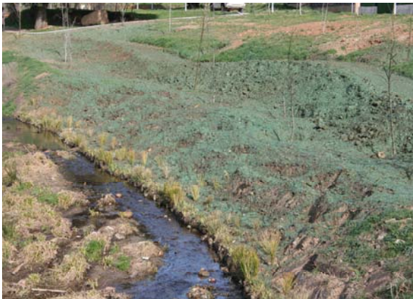
Imágenes de la hidromanta HydraCX2 una vez proyectada, con los Fiber Roll™ en primer término con los helófitos aún con aspecto invernal.
