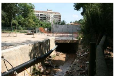
Imágenes antes de la intervención,
