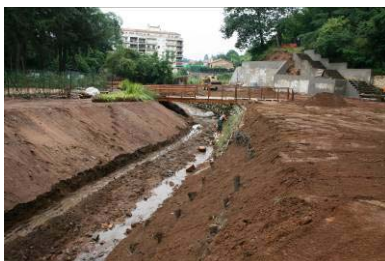
durante los trabajos,
