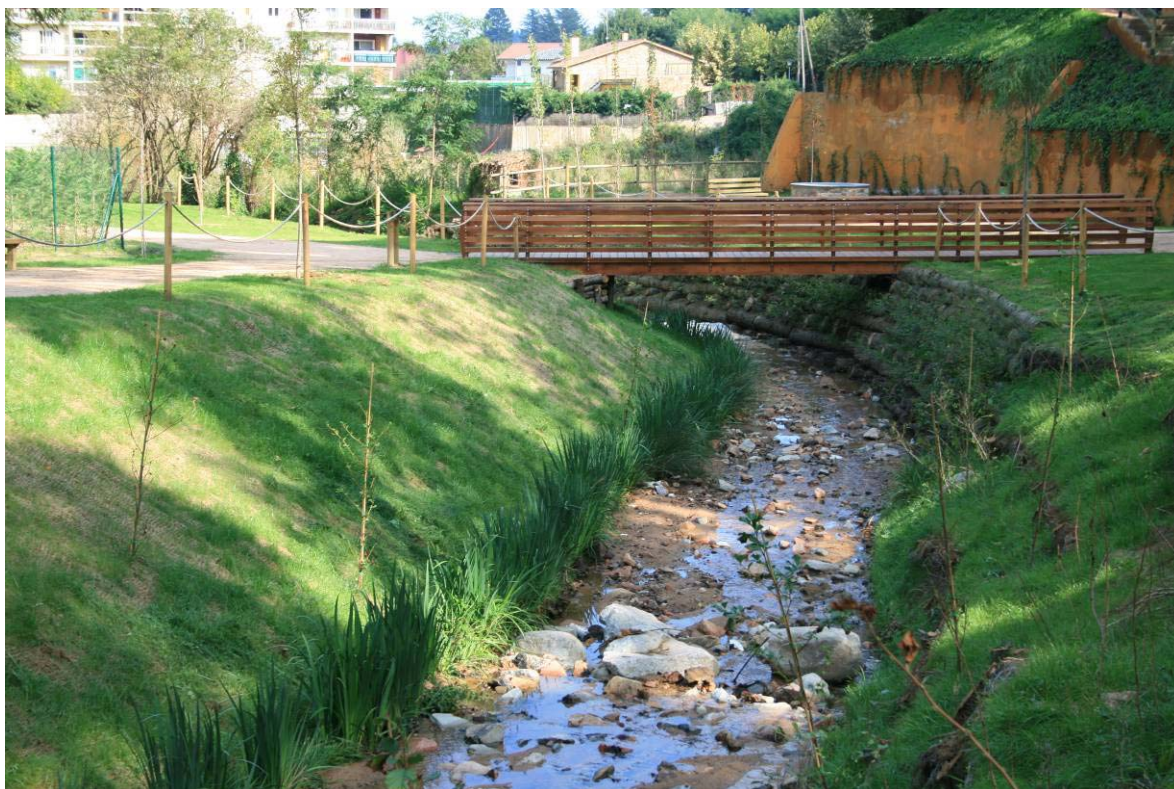
La zona restaurada pocos meses después de los trabajos
