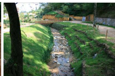
y ya finalizada la restauración.
