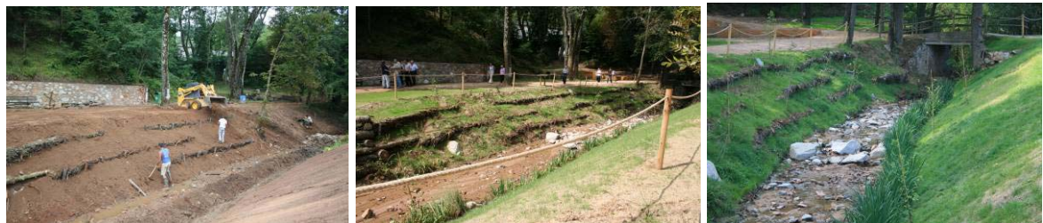
Durante y después de la restauración
