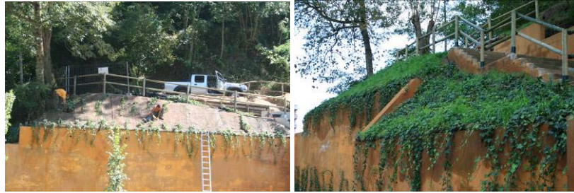
Instalación de geomalla C350 para estructurar drenajes y un talud
