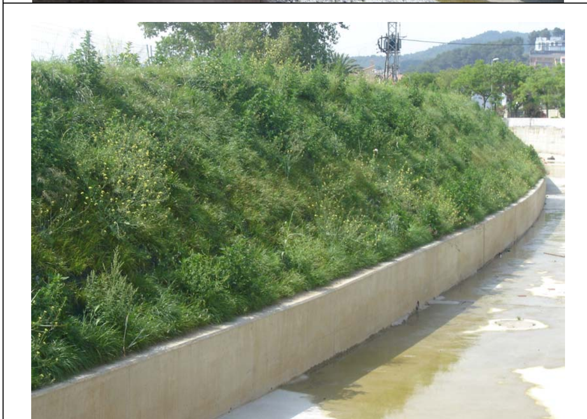
Imágenes 3 meses después de finalizar la obra.
