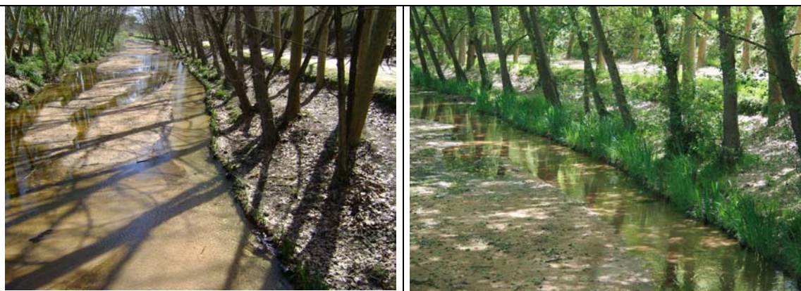
Foto izquierda: Fiber rolls™ después de la instalación.
