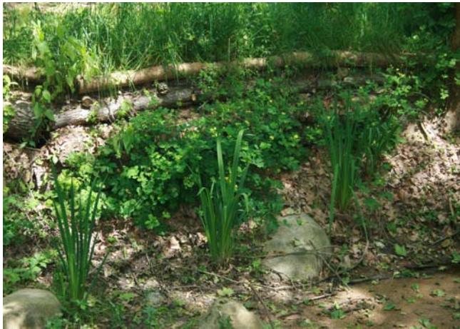
Foto izquierda: Plant plugs™ instalados en la base de un entramado, estructura de ingeniería naturalística
