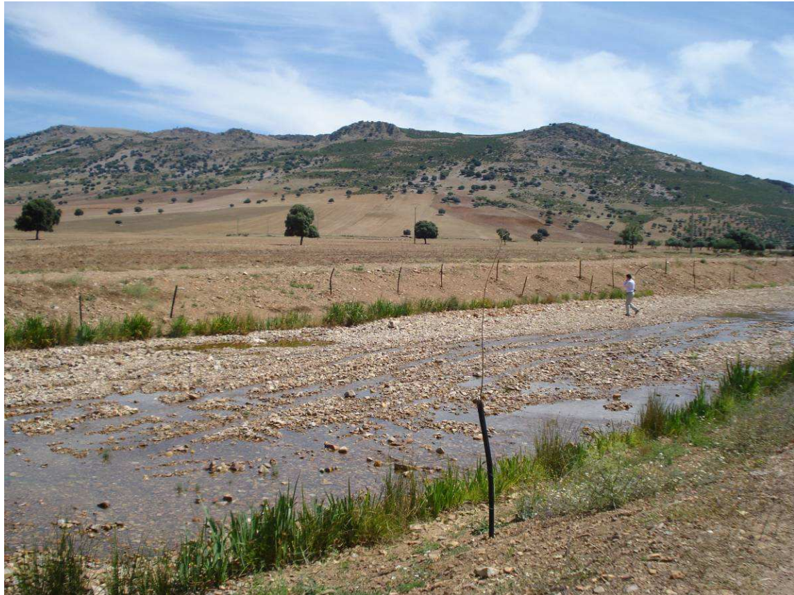
En estas imágenes tomadas en verano se aprecia la perfecta adaptación de los helófitos autóctonos a la reducción del caudal circulante. En este tramo, el Fiber Roll™ vegetado está instalado en ambos márgenes.
