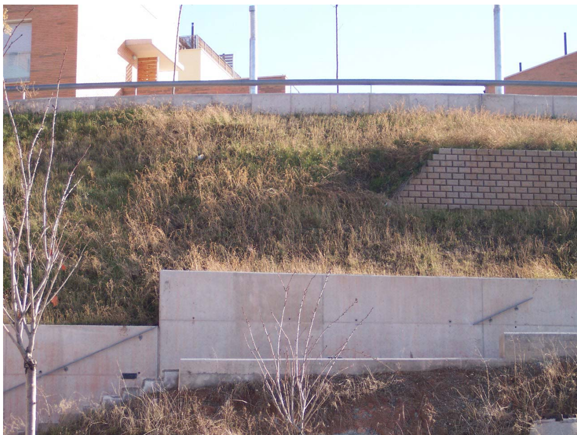
Imagen 1 año después de la instalación de la geomalla.
