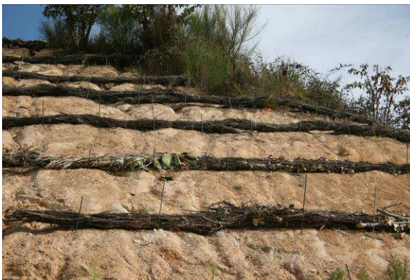
Construcción de fajas de rama seca.
