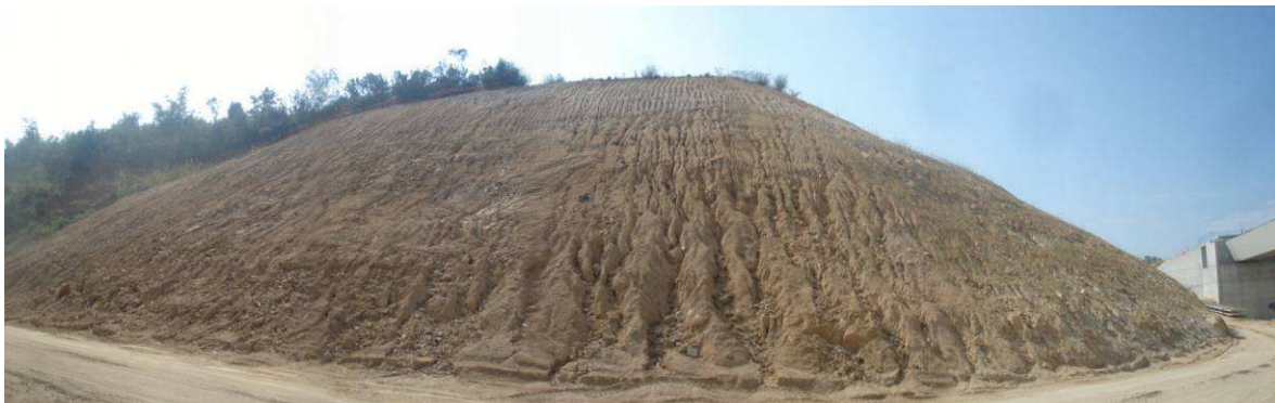
Imagen del talud antes de iniciar los trabajos
