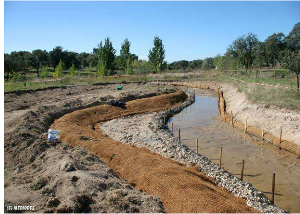
Inicio de los trabajos de excavación y instalación de los materiales de bioingeniería.
