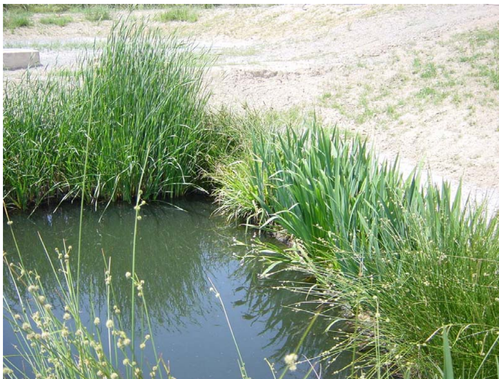
Detalle de la laguna de afinamiento
