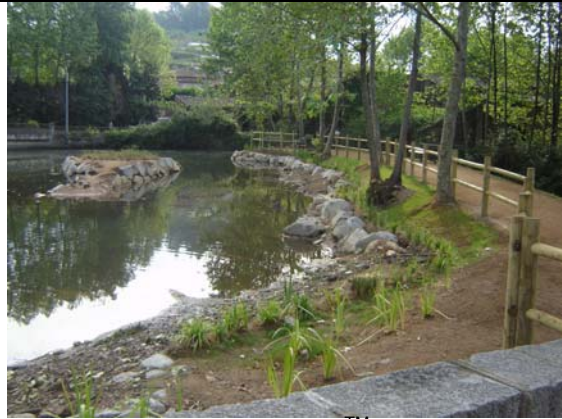
Instalación de Fiber roll™ vegetado.
