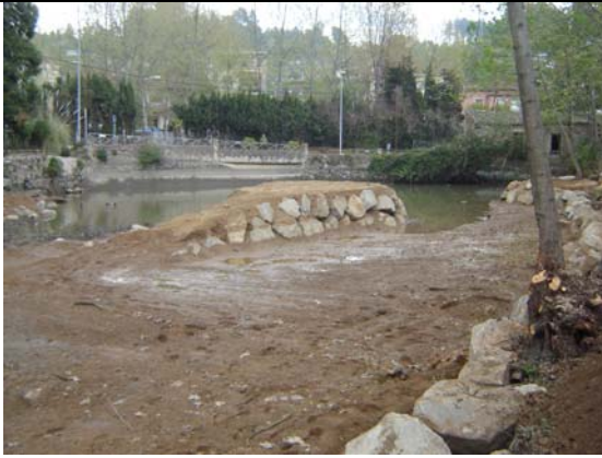
Imagen de la obra antes de la instalación
