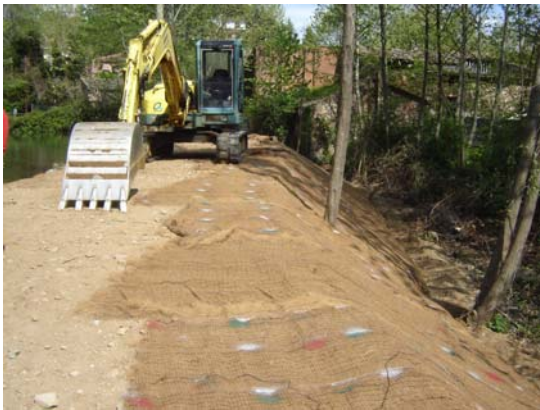
Instalación de la geomalla C-125BN de NAG.
