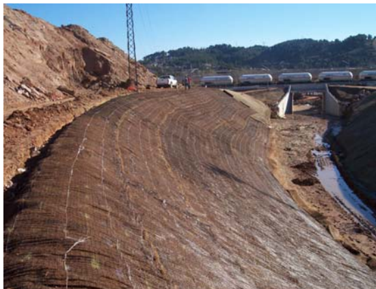
Instalación de la geomalla a lo largo de todo el talud.
