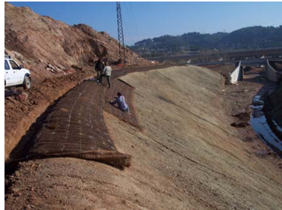
Hidrosiembra y anclaje superior de la geomalla NAG C-350.
