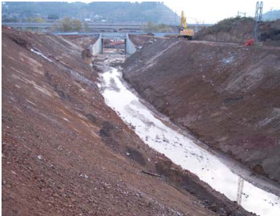
Reperfilado de los taludes.
