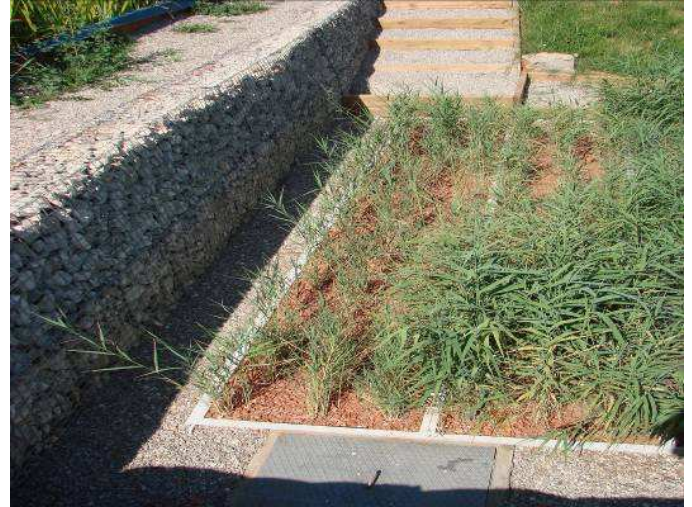
Ejemplo de sistema de flujo subsuperficial
