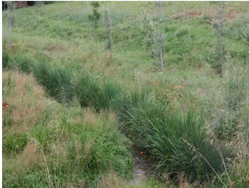
Imagen de un tramo de la obra seis meses después de finalizados los trabajos. En primer término los Fiber Roll™ vegetalizados ya desarrollados.
