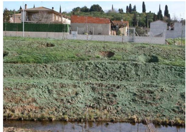
Imágenes de la hidromanta HydraCX2 una vez proyectada, con los Fiber Roll™ en primer término con los helófitos aún con aspecto invernal.
