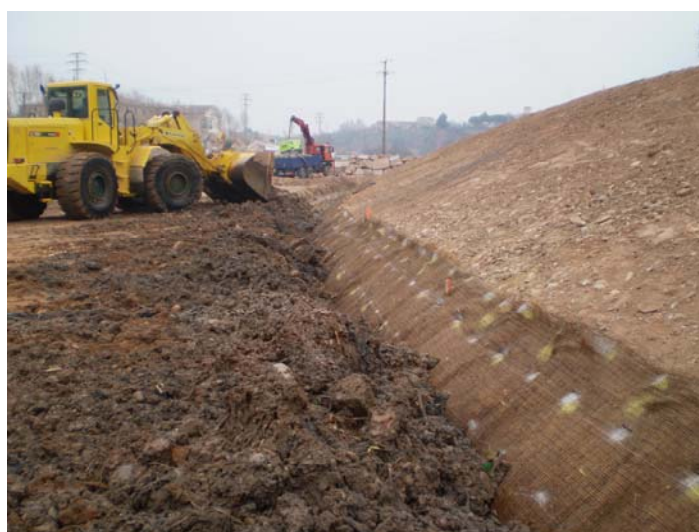
Instal·lació dels Rock roll™ (gabió flexible) amb mitjans mecànics al fons de la rasa, trepitjant la geomalla C350 de NAG. En la darrera foto s'aprecia el terraplenat de la rasa.
