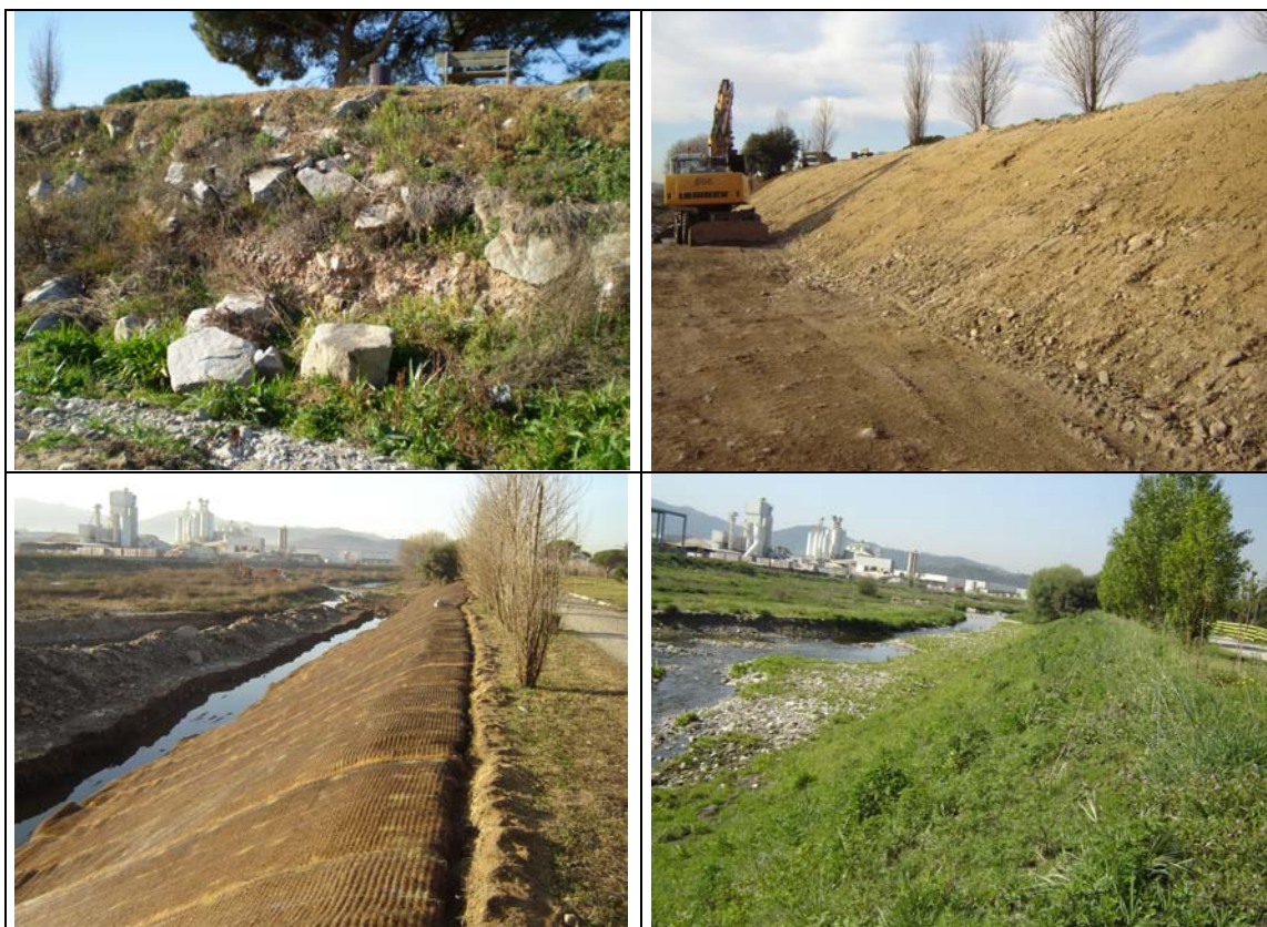
Substitución de escullera por geomalla permanente C-350 (después de 3 meses)
