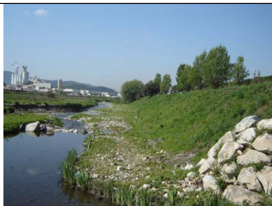
Foto izquierda: en primer termino Fiber roll™ vegetado y geomalla permanente C-350 en el río Congost.
