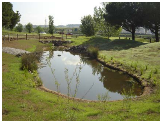
Foto izquierda: en primer termino Fiber roll™ vegetado y geomalla permanente C-350 en el río Congost.
