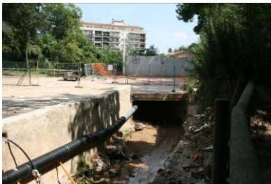
Imatges abans de la intervenció,
