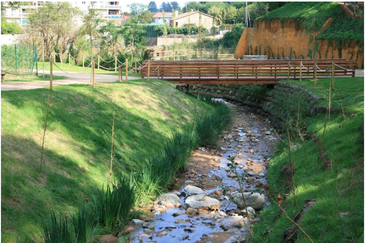
La zona restaurada un mes després dels treballs
