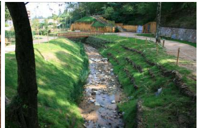
i finalitzada la restauració.
