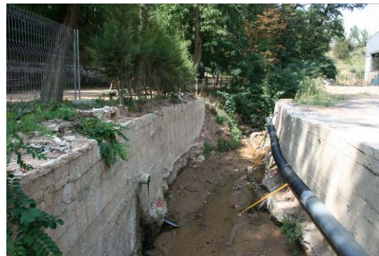
Imatges de la zona abans de la intervenció amb el col·lector penjat a la llera i una total degradació de l'espai.
