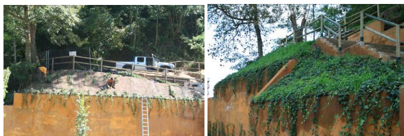
Instal·lació de geomalla C350 per estructurar drenatges i un talús
