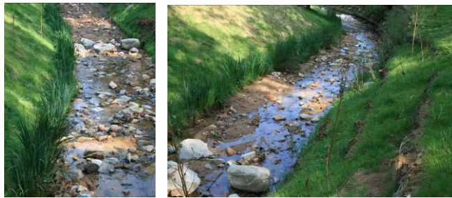
Imágenes de los Fiber roll™ vegetados ya instalados en el cauce
