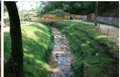
y ya finalizada la restauración.
