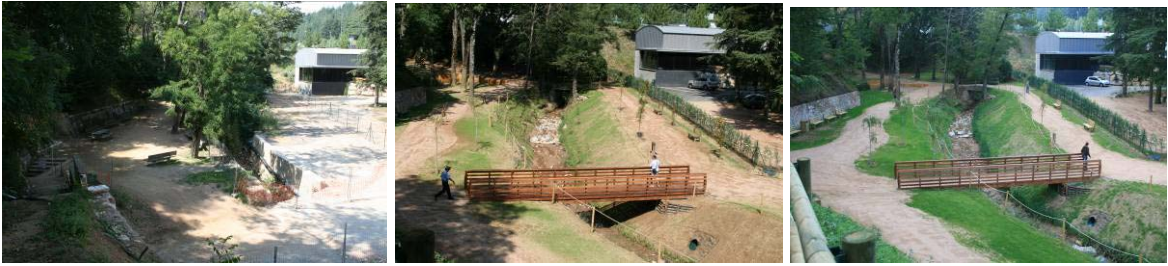
Antes y después de la restauración
