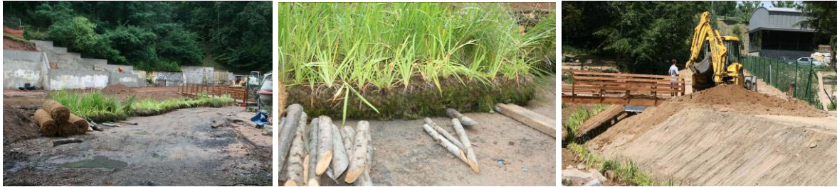
Imágenes de los Fiber roll™ vegetados antes de su instalación
