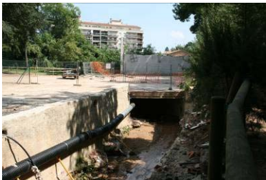
Imágenes antes de la intervención,
