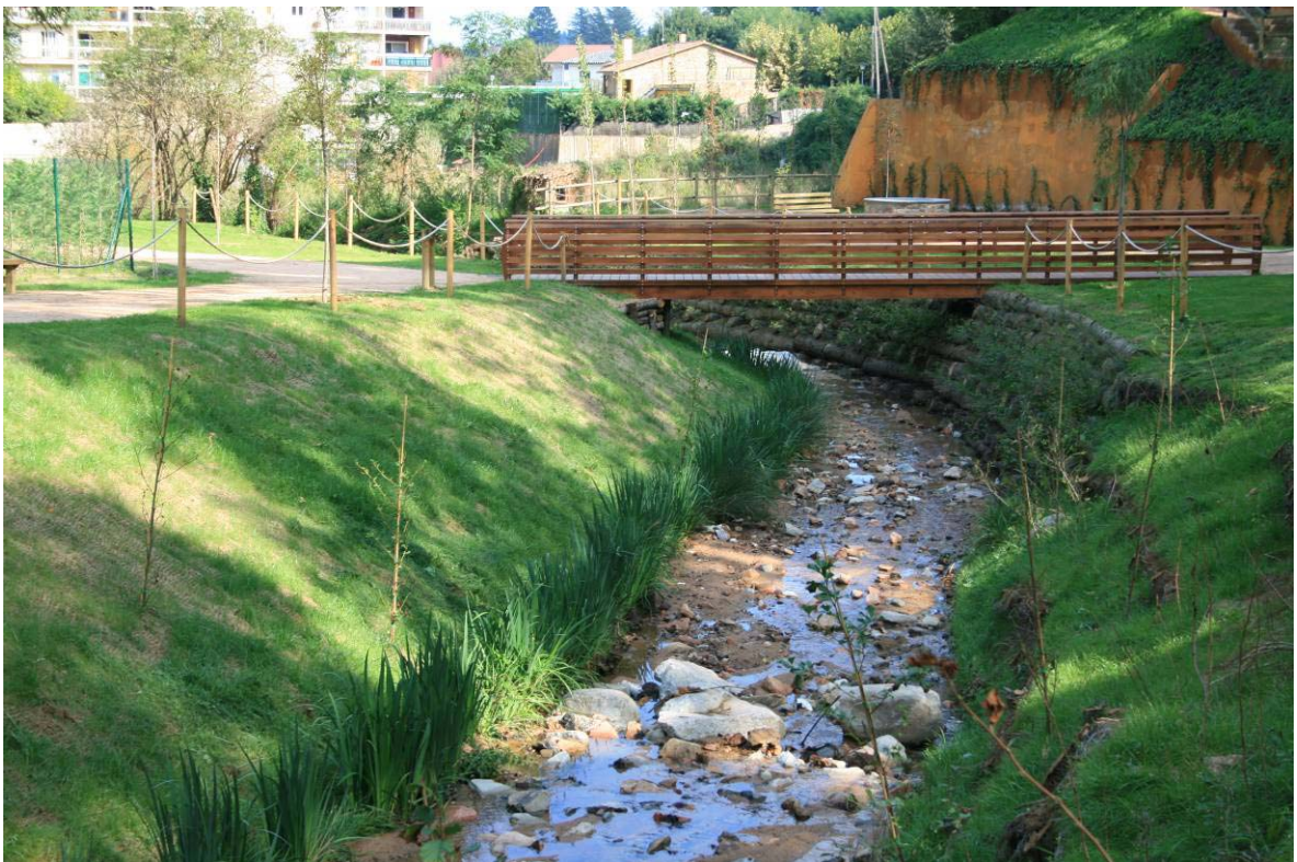
La zona restaurada un mes después de los trabajos
