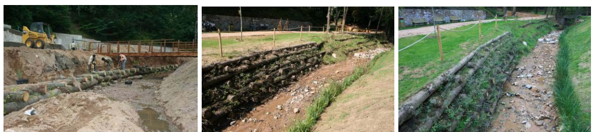
Durante la construcción de un entramado tipo Kriener y una vez finalizado
