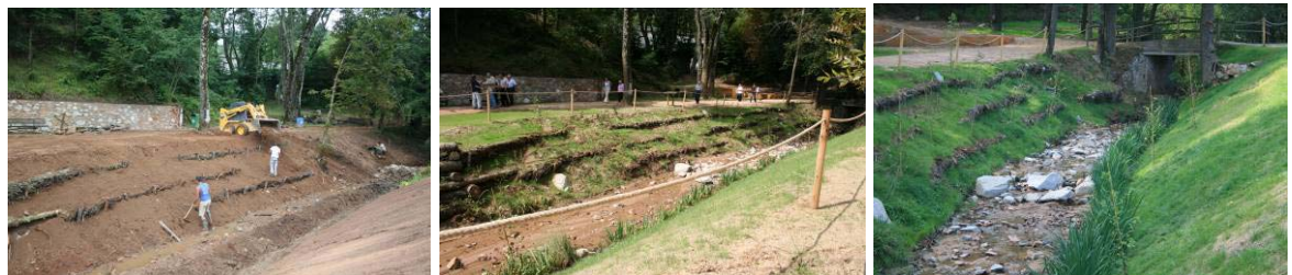
Durante y después de la restauración
