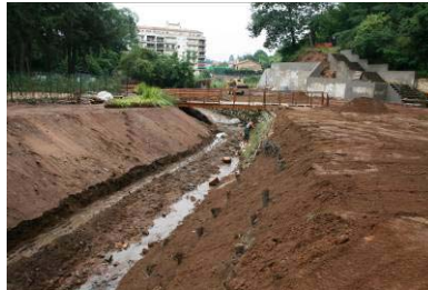
durante los trabajos,
