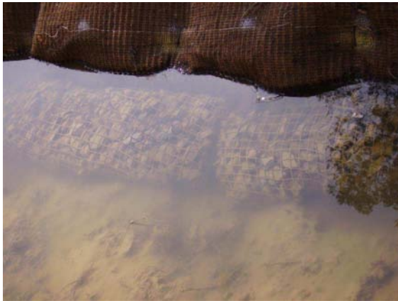
Imatges del gabió flexible Rock Roll™ fixant la geomalla i estabilitzant la base per la posterior instal·lació del Fiber Roll™.
