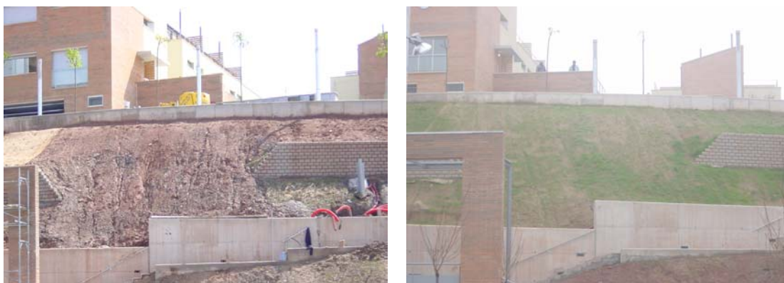
Imagen antes y una vez instalada la geomalla.
