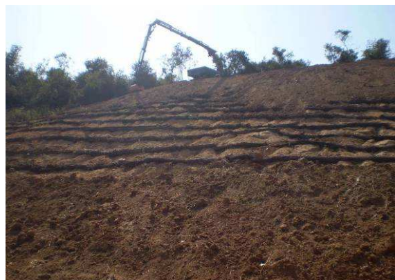
Construcció de feixines de branca seca.
