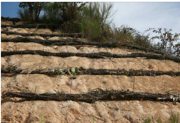
Construcció de feixines de branca seca.
