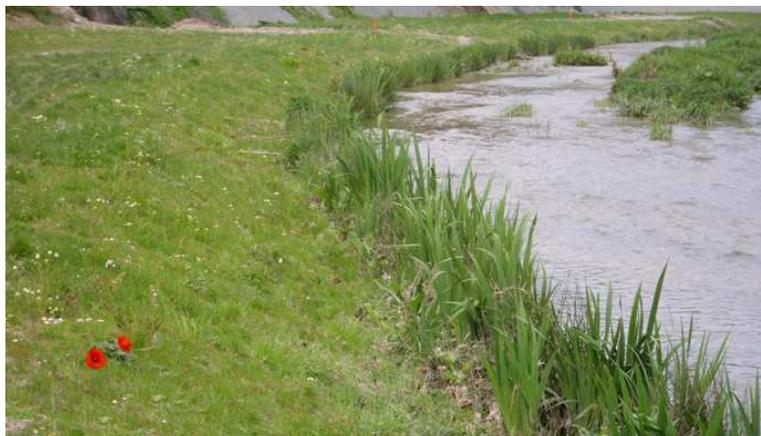
La aplicación del HydraCX2 y la instalación de la geomalla C350 Vmax han permitido sustituir parte de la escollera prevista inicialmente en todo el margen de aguas altas hasta la coronación.
