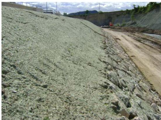
La proyección de la hidromanta HydraCX2 (previa a la instalación de la geomalla) consigue una densidad mayor y un crecimiento más rápido de la vegetación herbácea si se compara con una hidrosiembra convencional.
