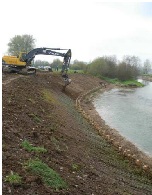
Ejecución de una cobertura de ramas. Fuente: ESWEG
