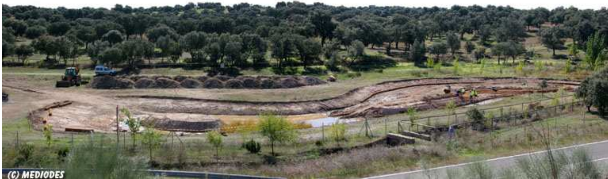
Vista general de la charca ya excavada
