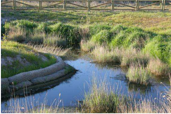
Detalle de los Plant Pallet ya enraizados en la charca, 5 meses después de acabados los trabajos.
