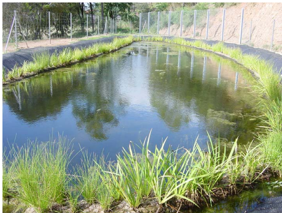
Septiembre de 2003, una vez finalizada la instalación.
