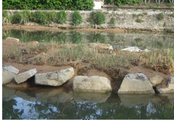
Plantación de Plant plug™ en la escollera, y Plant pallet™ en la isla.
