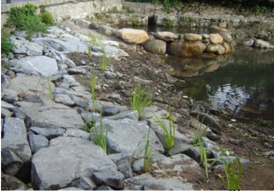
Plantación de Plant plug™ en la escollera, y Plant pallet™ en la isla.
