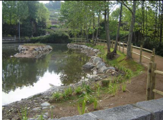
Instalación de Fiber roll™ vegetado.
