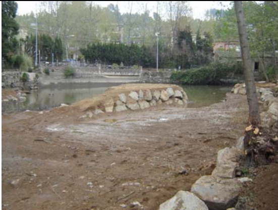
Imagen de la obra antes de la instalación
