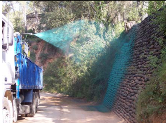
Detalle de la hidrosiembra del muro
